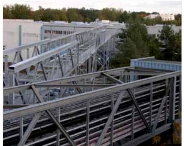
Die Brücke für die 168 Meter lange Transferleitung steht bereits.
