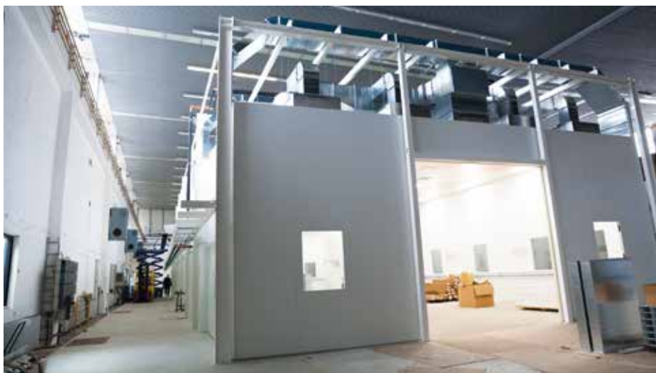
Aufbau der Reinraumanlage in Halle 1 für die Montage und Integration der Detektoren. Foto: Barbara Warmbein
