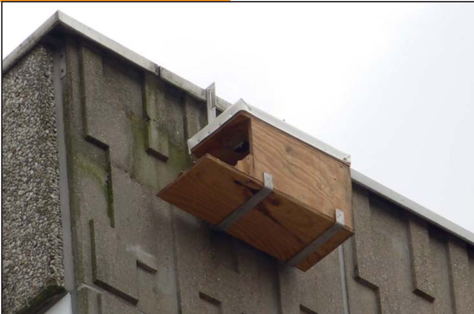
An Gebäude 2a hängt der Nistkasten, der auch dieses Jahr wieder von den Turmfalken bezogen wurde.
