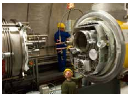
Das siebte Beschleunigermodul wird im FLASH-Tunnel installiert.
