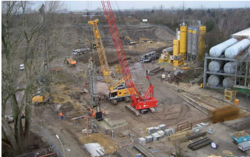
Die Baustelle DESY-Bahrenfeld am 13. März. Der rote Kran arbeitet an dem ersten Eckstück der Baugrubenwand. Im Hintergrund wird die Böschung des Lise-Meitner-Parks abgetragen.
