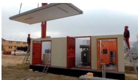
Die Kompaktstation für die Stromversorgung der Baustelle Schenefeld wird aufgestellt. Dahinter steht das gelbe Bürogebäude der Baufirmen.
