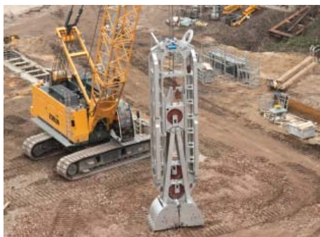
Die eckige Schaufel des „Schlitzwandgreifers“ kurz vor ihrem ersten Einsatz
