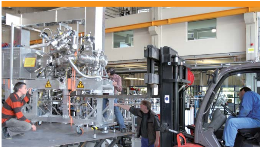
DESY-Kollegen unterstützen auch bei Auf- und Abbauarbeiten der sensiblen Messapparaturen.
