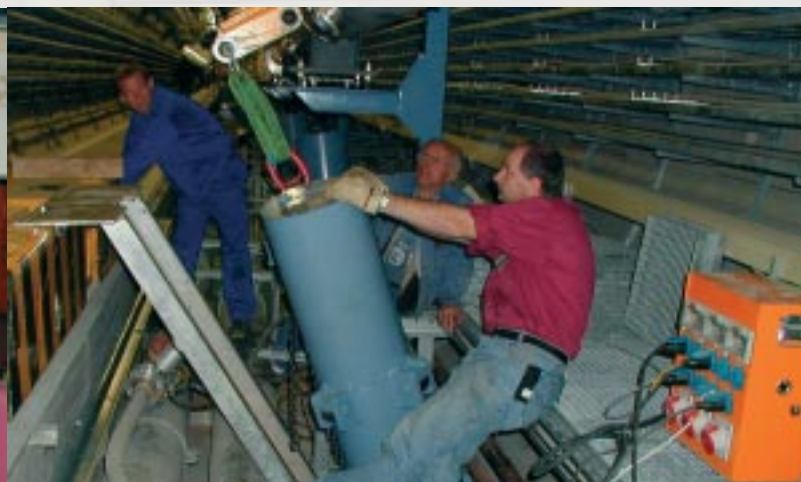
Aufbau der Stützen für die Spinrotatoren: Wie auf einer Hebebühne kann der Beschleuniger in diesem Bereich auf und ab gefahren werden.
