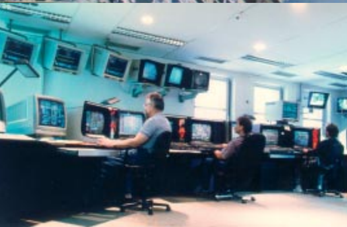
Im Kontrollraum der HERA-Kälteanlage
