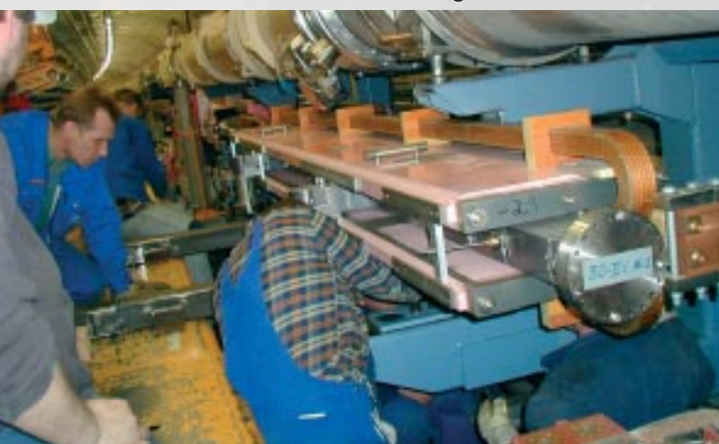
Neu eingebaute Spinrotatoren erlauben es auch den Experimenten H1 und ZEUS, den Spin der Elektronen für ihre Untersuchungen zu nutzen.
