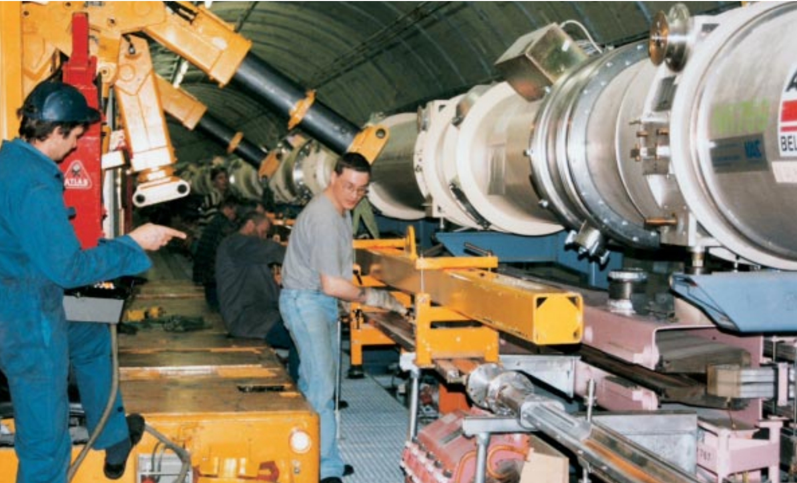
Fünf Kilometer Vakuumkammer mussten ausgebaut werden, um HERA für den Betrieb mit Elektronen umzurüsten. Die gelbe „HERA-Tram“ transportiert die schweren Beschleunigerkomponenten an Ort und Stelle.
