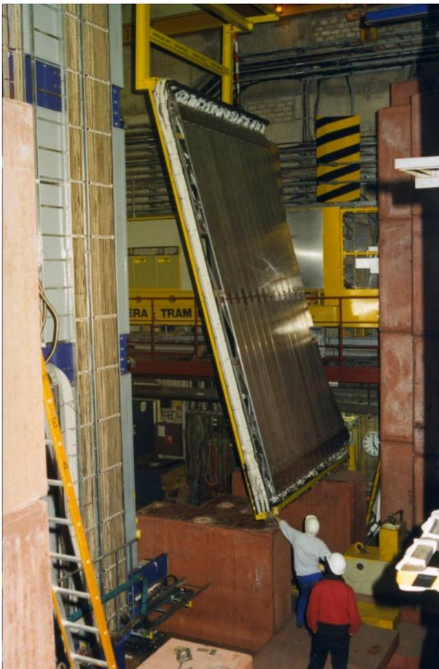
Abbildung 37: Installation der Myon-Kammern.
