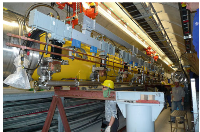
Abbildung 70: Modul PXFEL1 beim Einbringen auf FLASH-Position ACC7.
