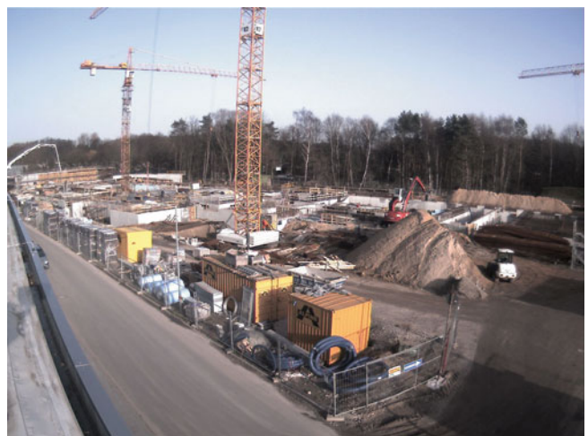
Abbildung 20: Das CFEL Baugelände gegenüber von der PETRA-III-Halle im November 2009.
