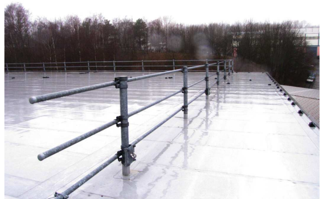
Abbildung 196: Dach von Gebäude 80.
