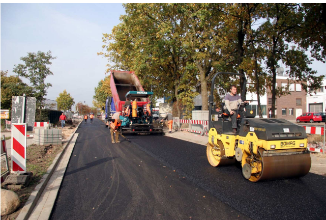
Abbildung 199: Ausbau der Zufahrtsstraße Holzköppl.
