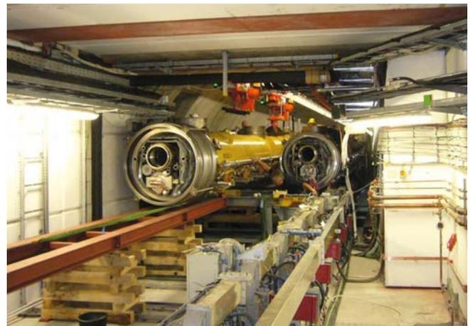
Abbildung 154: Modul 5 beim Einbringen in den FLASH-Linac.
