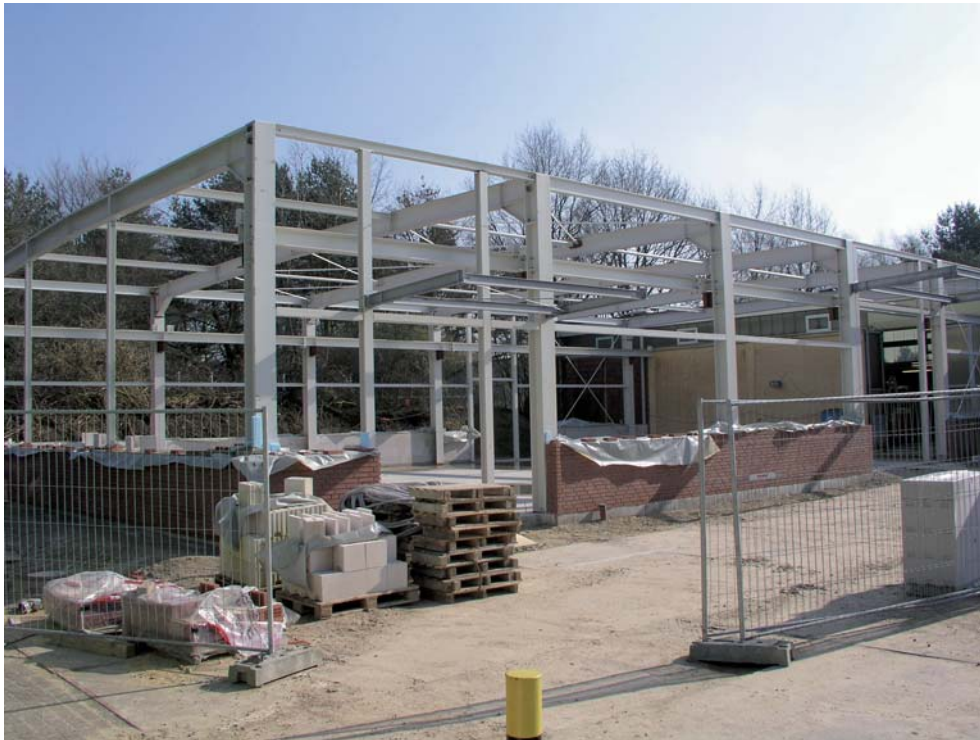
Abbildung 176: Anbau Gebäude 18, Erweiterung der Schweißhalle (rechts).
