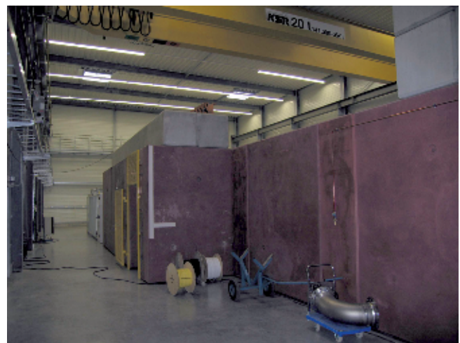
Abbildung 154: In der Modulteststand-Halle sind bereits die ebenfalls 2005 gelieferten Abschirmsteine aus Normal- und Schwerbeton aufgebaut worden. Der Schwerbeton ist infolge des Eisenerzes rötlich gefärbt.
