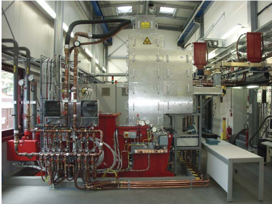
Abbildung 100: Aufbau der 2. RF-Station.
