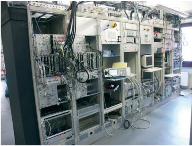
Abbildung 91: Von der Gruppe aufgebautes Elektronik-Rack in der Klystronhalle.
