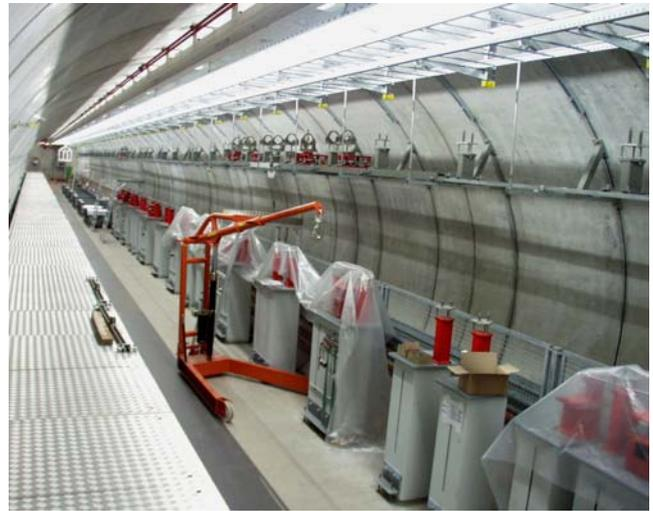
Abbildung 152: *Blick in den TTF2-Tunnel mit Strahlführungsunterbauten.*
