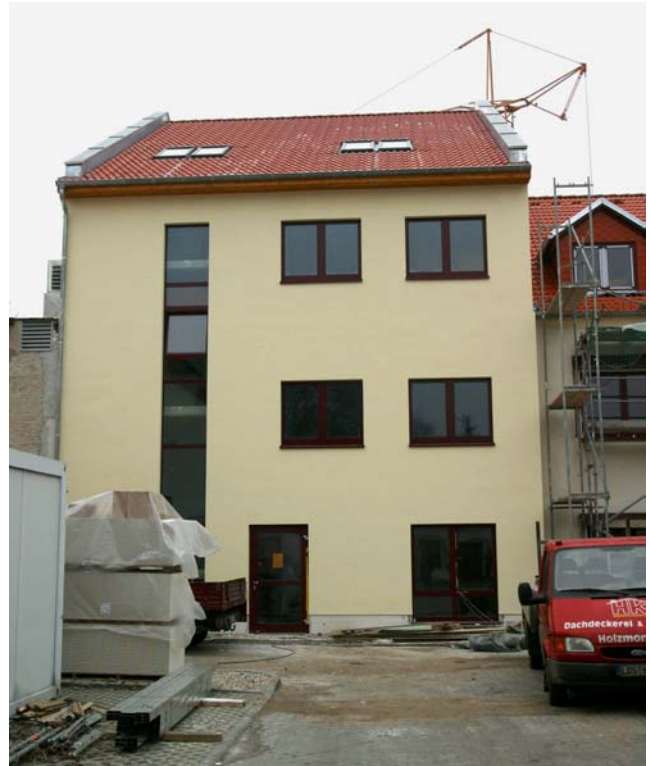
Abbildung 110: Laborgebäude II nach Sanierung und Aufstockung.
