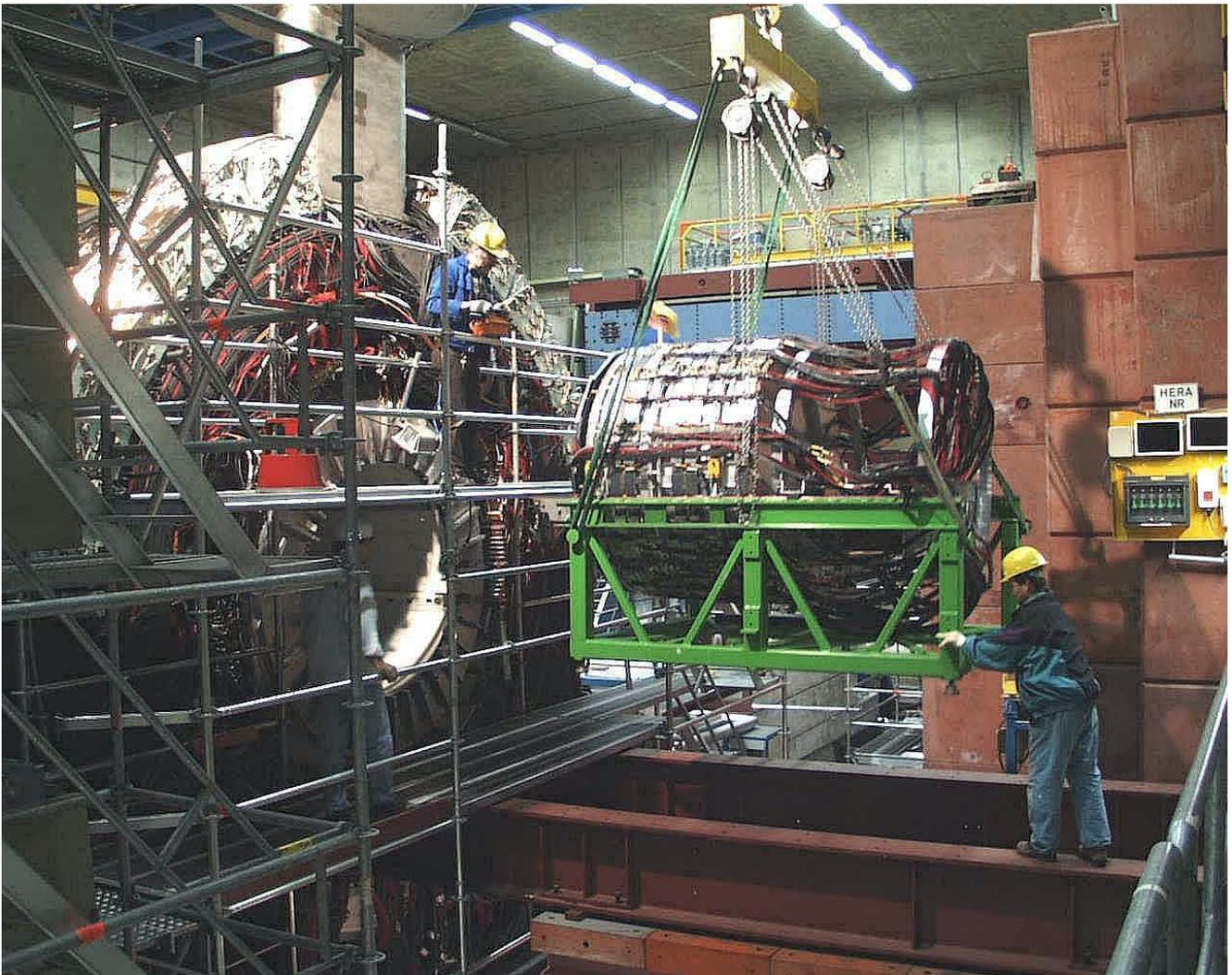
Abbildung 2: Die neuen Vorwärtsspurkammern vor dem Einbau in den H1-Detektor.
