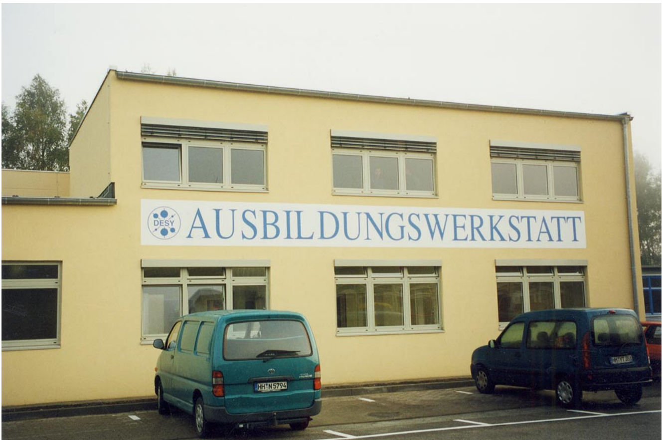
Abbildung 127: Anbau der Ausbildungswerkstatt.
