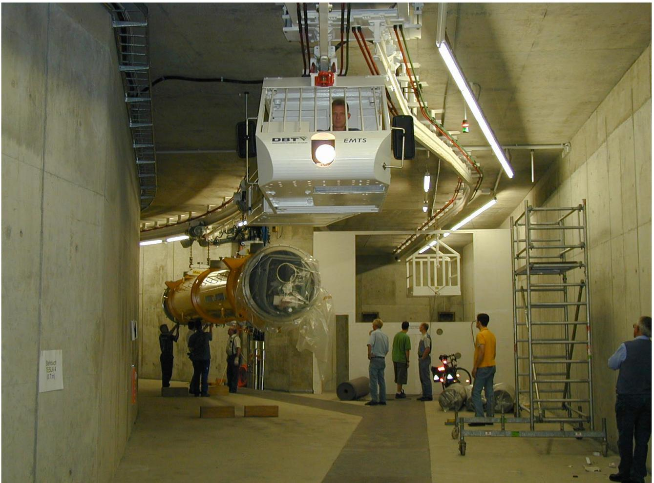
Abbildung 128: Einbau eines Beschleunigermoduls im TTF-Tunnel.
