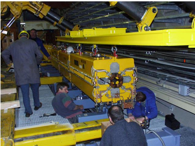
Abbildung 133: Einbau der Quadrupolmagnete Typ GN.
