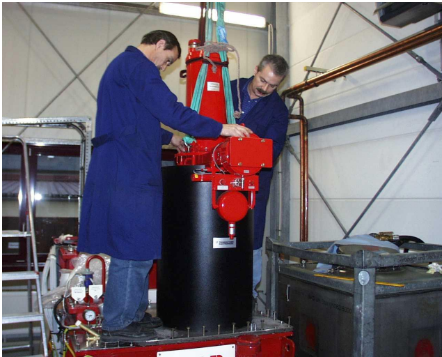
Abbildung 99: Installation eines 5 MW Klystrons für PITZ.
