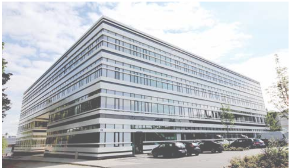
Das fertiggestellte CSSB-Gebäude. Foto: Till Mundzeck, DESY.
