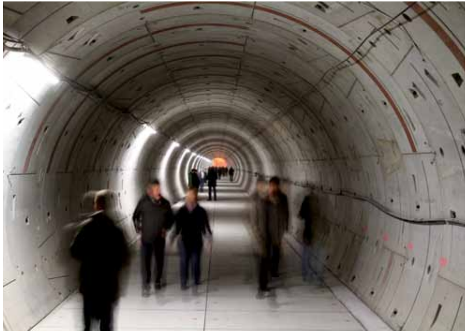
2013 sollen hier die ersten Beschleunigermodule stehen: Der Tunnel für den European XFEL ist fertig (Foto: M. Mayer)
