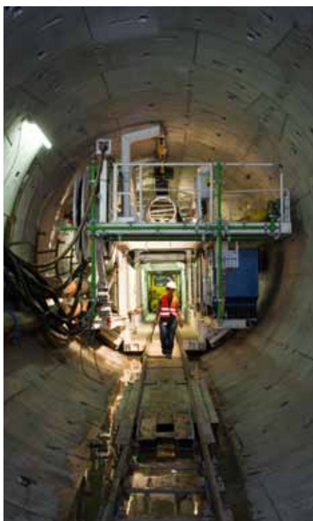
Blick auf das Ende von TULAs Nachläufer, nachdem etwa 100 Meter Tunnelröhre fertiggestellt wurden.
