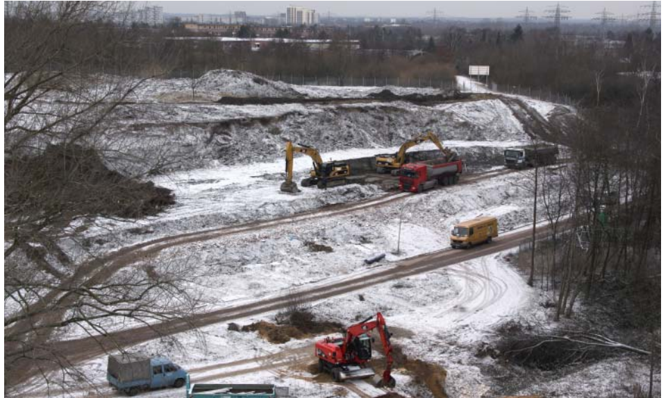
Blick auf die Baustelle DESY-Bahrenfeld hinter dem Laborgebäude 2: Der Boden des Lise-Meitner-Parks wird abgetragen.
