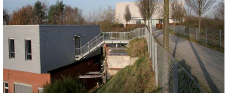
Das neue Stockwerk von Gebäude 49 mit (fast) direktem Zugang zur FLASH-Halle
