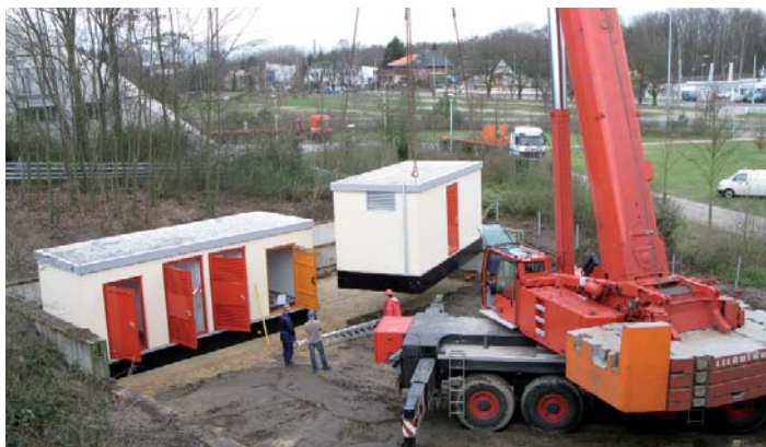
Am Haken: Für PETRA III wurden schon neun neue Trafostationen aufgestellt.
