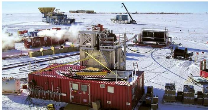
Im Vordergrund steht der rote IceCube-Bohr- und Installationscontainer, dampfend im Hintergrund der Durchlauferhitzer für das Bohrwasser.
