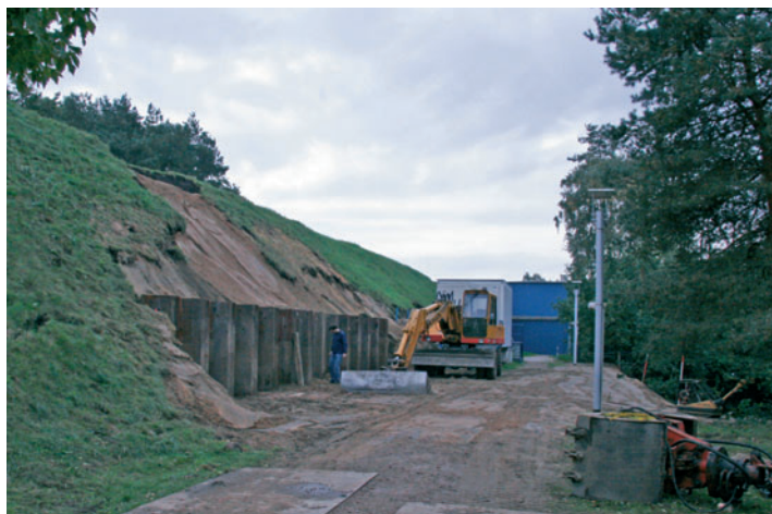
Die Baustelle für das Laserdiagnostik-Gebäude am FLASH-Wall im Oktober 2006
