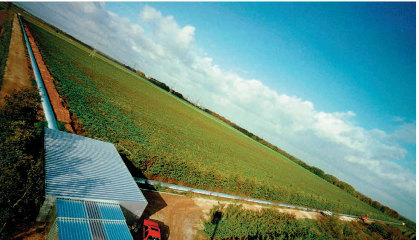
Abb. 28: Das südlich von Hannover gelegene GEO600. Man erkennt die beiden senkrecht zueinander liegenden, 600 Meter langen Arme des Interferometers und das Zentralhaus, in dem sich Laser, Strahlteiler und Signalaufnahme befinden.
