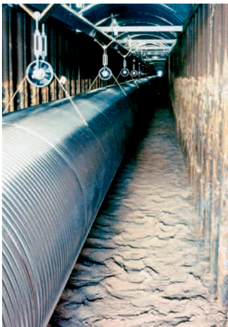
Der Laserstrahl von GEO600 läuft in evakuierten Röhren, die vibrationsfrei aufgehängt sind.
