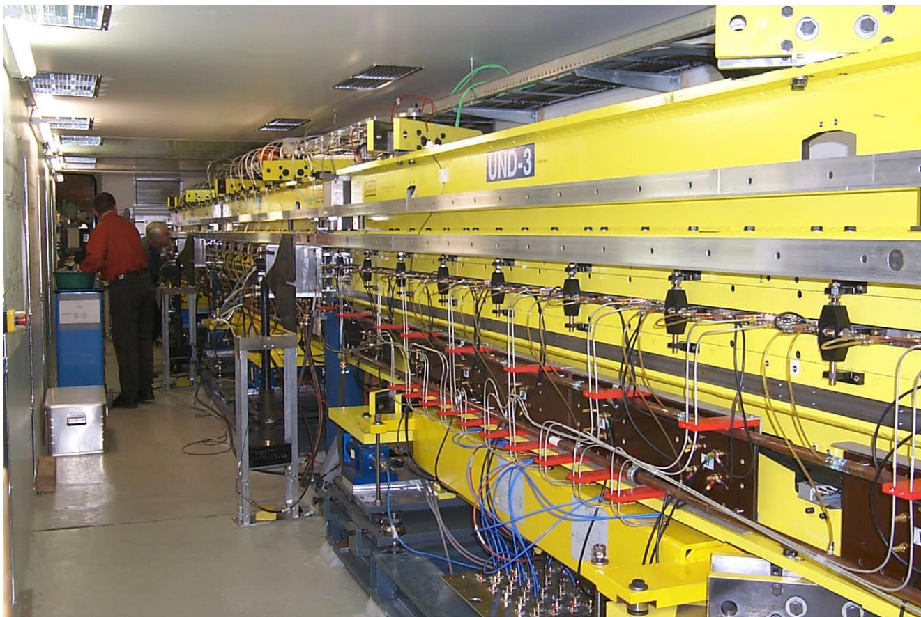
Abbildung 95: Der Undulator für den TTF FEL nach seinem Einbau in den Beschleuniger. Die Vakuummkammer für den Elektronen-Strahl befindet sich in der Mittelebene, zu erkennen an den vielen Signal- und Stromversorgungskabeln, die dort hinein- und herausführen.
