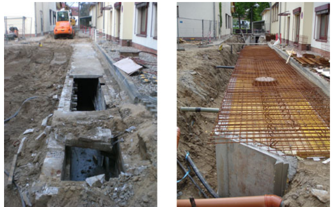
Abbildung 128: Sanierung des Medienkanals.
