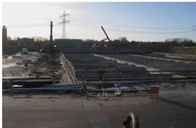
Abbildung 140: Flächenmäßig größte Baugrube (55 m x 95 m) für die unterirdische Experimentierhalle.
