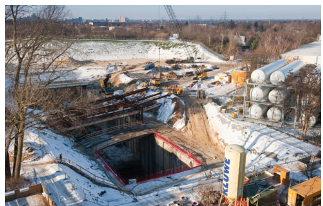
Abbildung 136: Die mit 33 m tiefste und mit annähernd 100 m Länge auch die längste Baugrube XSE des XFEL-Baus auf dem DESY-Gelände, gut zu erkennen ist der große Aufwand für die Abfangung der querenden Kabel- und Leitungstraßen.
