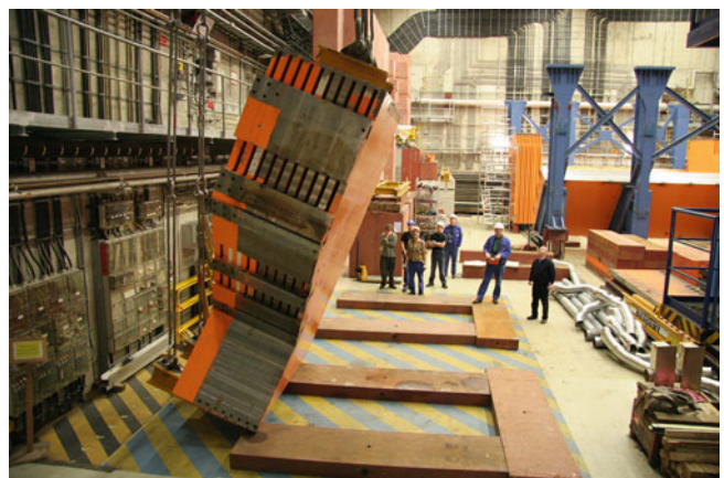
Abbildung 80: Abbau des ZEUS Eisenjochs.
