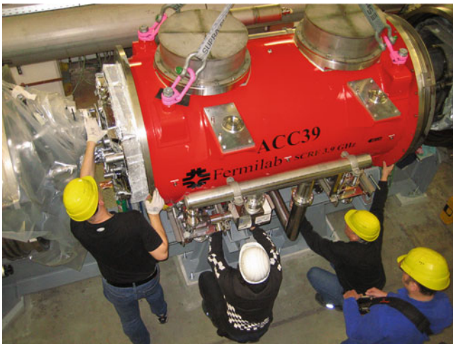
Abbildung 38: Das neue Modul mit vier supraleitenden 3.9 GHz Cavities beim Einbau in FLASH.
