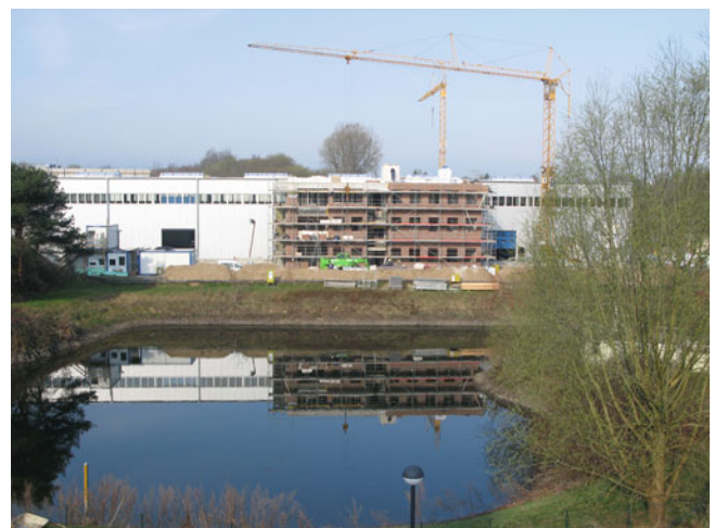
Abbildung 39: Blick auf die im Bau befindliche Halle für die Accelerator Module Test Facility (AMTF) im Herbst 2009.
