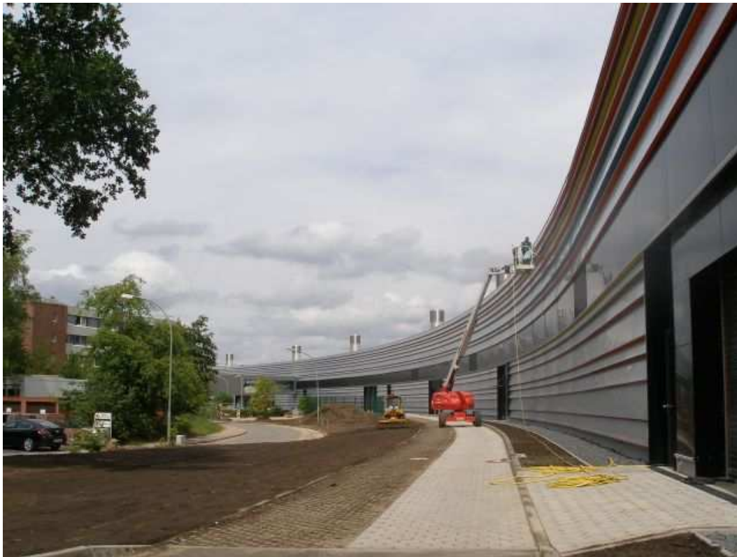
Abbildung 197: Fassade der PETRA-III-Experimentierhalle.
