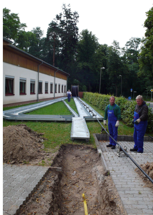
Abbildung 125: Verlegung des Puls-kabels.
