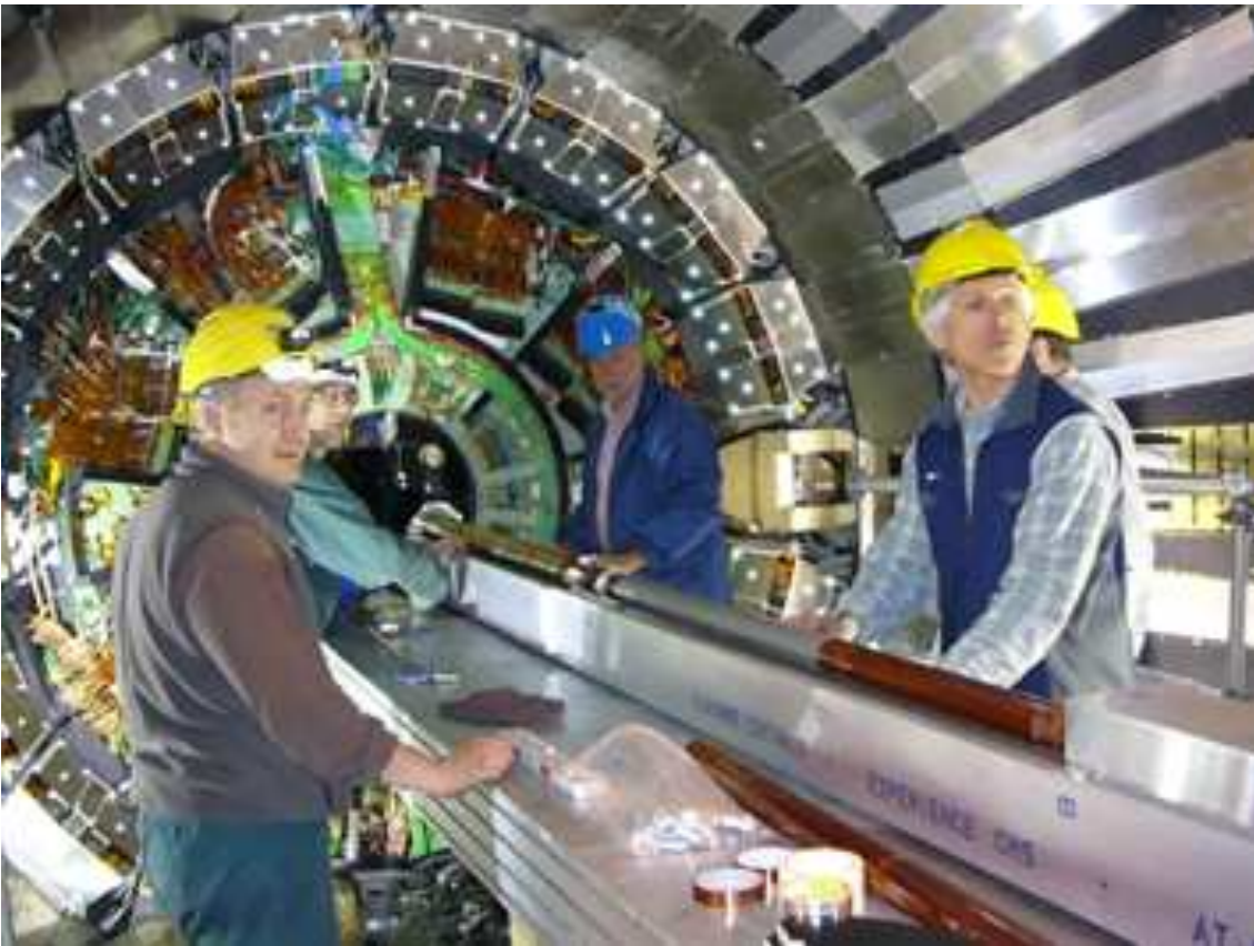
Abbildung 59: Einbau des zentralen Strahlrohres.
