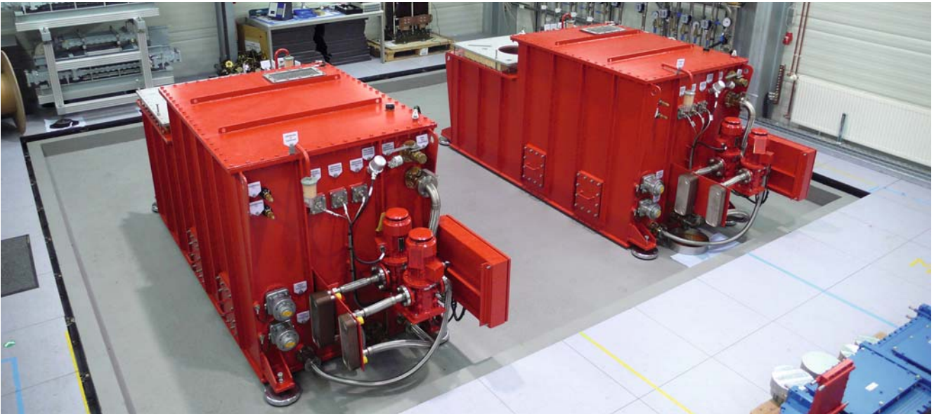
Abbildung 206: Montage der Ölwanne und Aufstellung der Pulstransformatoren bei MTF.
