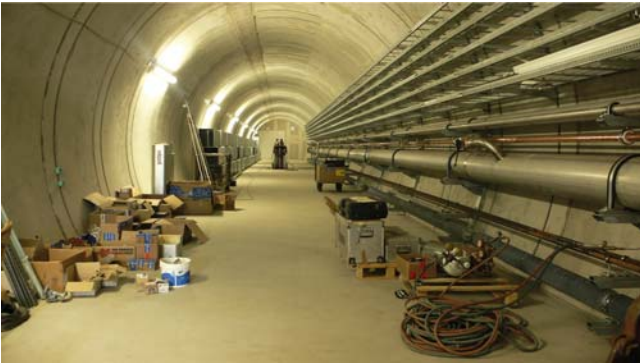
Abbildung 137: Blick in den XFEL Testtunnel.
