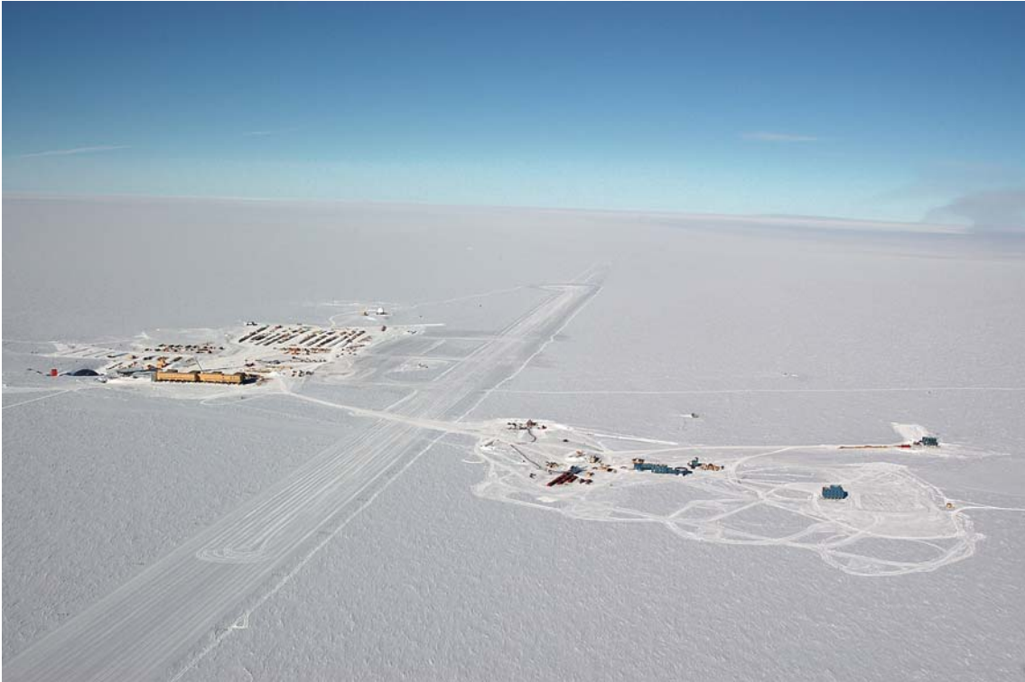
Abbildung 7: Blick über den Südpol. Die Südpol-Station links, rechts IceCube-Gebäude und -Geräte sowie ein Radioteleskop. Die roten Boxen vorne beherbergen Heizer und Pumpen, ein Schlauch führt das heiße Wasser zur Bohrstelle gleich neben der Landebahn.
