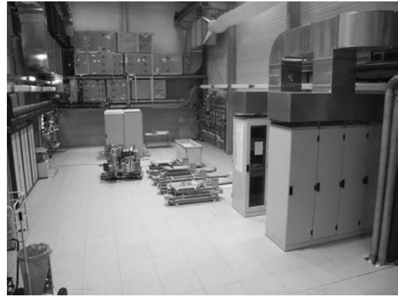
Abbildung 112: Blick in die fertig gestellte Modulator Test Facility (MTF) Halle.
