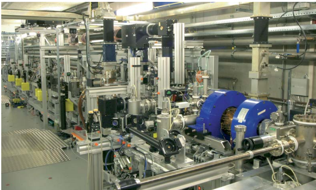
Abbildung 111: Blick auf die Anlage PITZ im November 2006.
