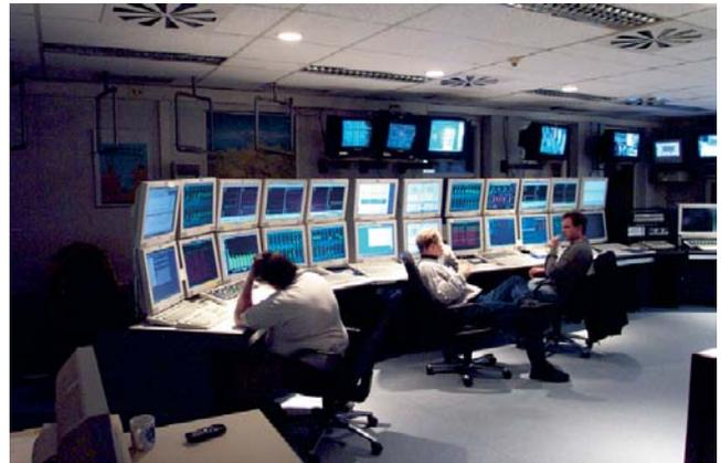
Abbildung 114: Bedienkonsolen des Kontrollsystems der HERA-Kälteanlage.
