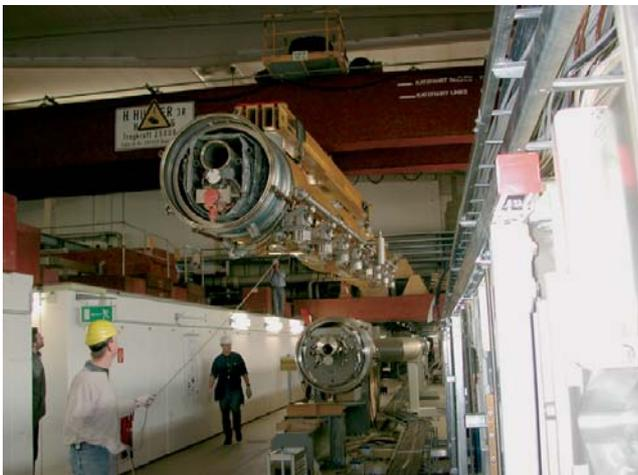
Abbildung 115: Installation des Kryomoduls Nr. 3\* im TTF-Tunnel.
