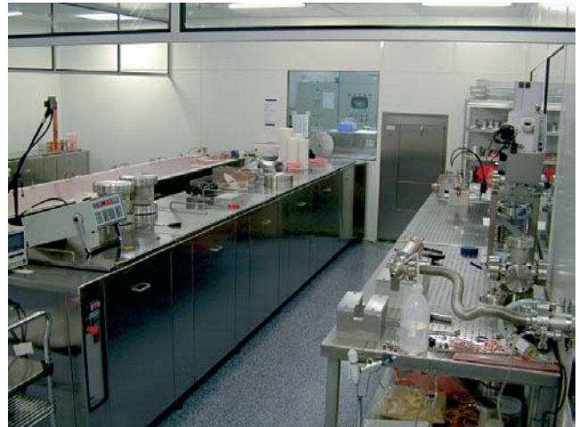
Abbildung 111: Blick in die neue Ultraschallreinigungsanlage mit Ultraschallbecken, Leitwertspülbecken, Trockner und Montagebereich (von links nach rechts).
