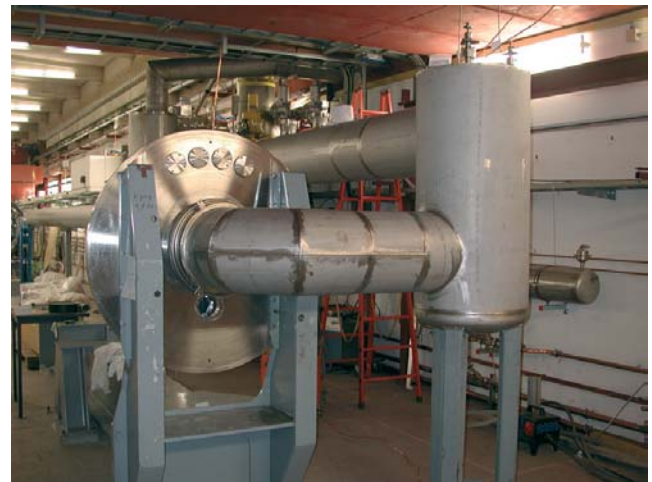
Abbildung 116: Kryogenische Komponenten im TTF-Tunnel.
