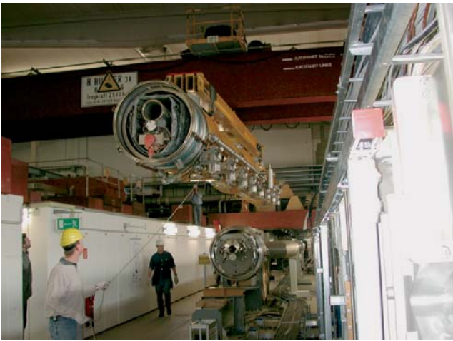
Abbildung 115: Installation des Kryomoduls Nr. 3* im TTF-Tunnel.
