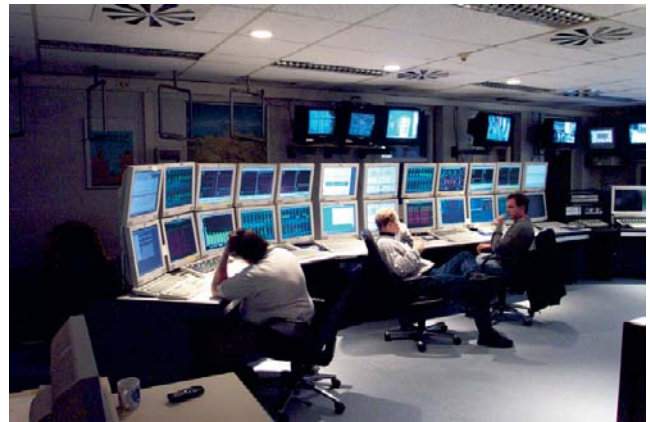
Abbildung 114: Bedienkonsolen des Kontrollsystems der HERA-Kälteanlage.
