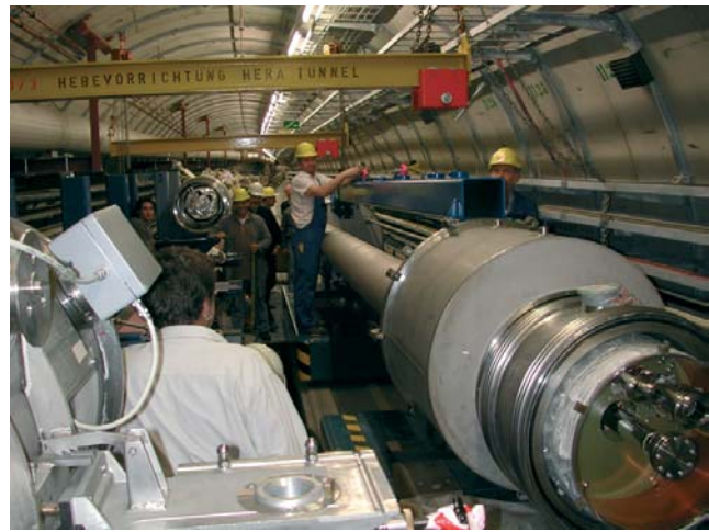
Abbildung 113: Transport der H1 VFPS-Bypass Transferleitung an die HERA Tunnelposition NL 220 m.
