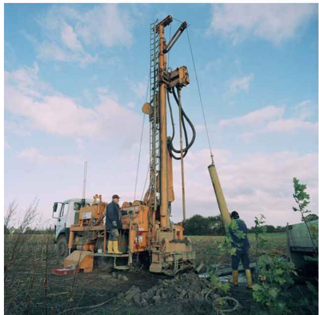
Abbildung 149: Bohrarbeiten zur TESLA-Vorbereitung.
