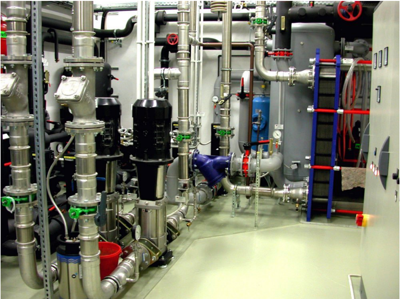
Abbildung 109: Die Kühlanlage des Photoinjektors. Die Anlage erlaubt es, die Temperatur der RF-Gun auf 0.10^{\circ}\text{C} zu stabilisieren.
