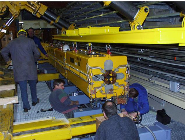
Abbildung 133: Einbau der Quadrupolmagnete Typ GN.
