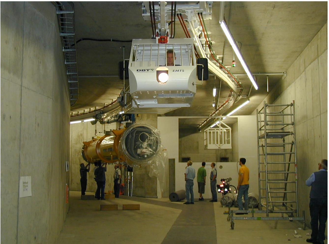
Abbildung 128: Einbau eines Beschleunigermoduls im TTF-Tunnel.
