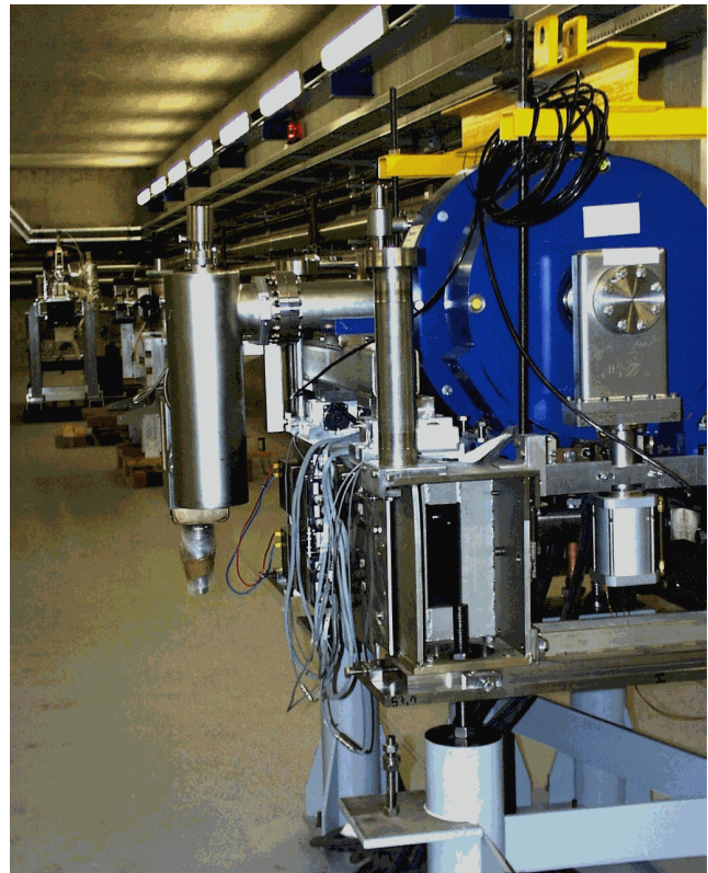
Abbildung 98: Im Vordergrund ist das Gestell des Hochfrequenz-Resonators mit den umgebenden Magneten im neuen Beschleunigertunnel gezeigt. Im Hintergrund sind Teile des Kathodensystems und des Diagnose-Gestells zu erkennen.
